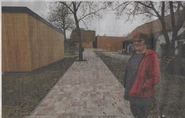
Marija Glavinč na gradbišču njihovih apartmajskih hišk, kajž, v Vinskem vrhu. Foto Jože Pojbič
